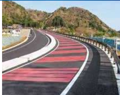
沼津河川国道事務所(静岡県)
