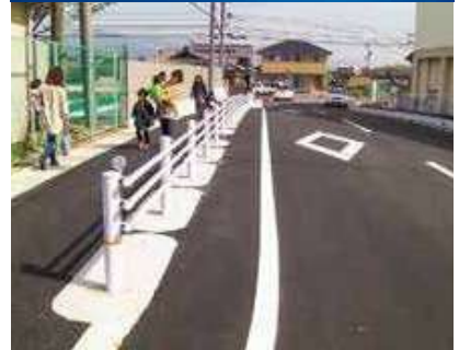
亀山市役所(三重県)
