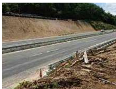
西日本豪雨災害 復旧工事にて
