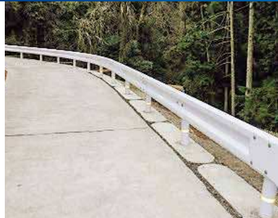
長浜土木事務所(滋賀県)
