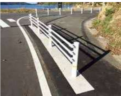
京都府丹後土木事務所 (京都府)
