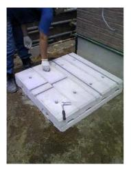
下部ブロックのレールに付属の M12×100 mm ボルトをセットし、残りのブロックを載せます。 19 mmボックスレンチを用い付属のワッシャー、スプリングワッシャー、ナットを、通常の人が手で締め付けられる程度の強さで締め付け 固定します。
