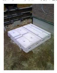
上面ブロックを固定したナット部をコーキング剤やモルタル等で埋め、外観を仕上げて完成とします。
