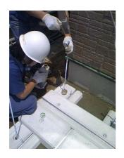
エコベースの貫通穴から地中抵抗アンカーを 差し込み、ハンマーで地中に打ち込みながら、 練り混ぜたフィルコンRを、打ち込んだアン カーの隙間に注入して下さい。時々アンカー を動かし、隙間によく入るように注入して下 さい。この作業により地中で鉄筋入りのコン クリートの柱が形成されます。
