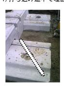
エコベース下部ブロック の上面でアンカーをカッ トし、カットしたアンカ ー上部を逆にして叩き面 を下にし斜めに打ち込み、 フィルコン R を流してコ ーティングして下さい。
