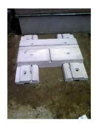
下部ブロックのレールを内側に置き、レール間 寸法を HE920=500mm、HE750=350 mmにします。 地中抵抗アンカーを打ち込む際下部ブロックが 動かないように付属の M12×100 mmボルトを中央にセットします。
