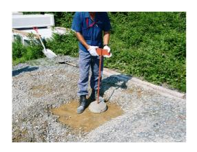
エコベースより広く土間を整地します。 砕石 150 mm以上、捨てコンクリート 30 mm程度分 掘り下げて、沈み込まなくなるまでしっかりつ き固めて下さい。可能であればランマでつき固めて下さい。砂質等で土間が締らない場合は、砂とセメントを混ぜて地盤整地を行う必要もあります。地中抵抗アンカーを打ち込むため、掘り下げた時に埋設物の位置をご確認下さい。
