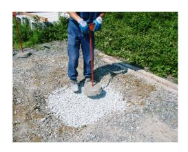
沈み込みを防ぐため砕石を敷き、つき固めます。 砕石サイズは 15~20 mm程度が目安です。
