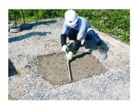
ドライコンクリート 25kg 2 袋をふねにあけ、 約 4 深弱の水で固めに練り混ぜ、捨てコンクリートを作り、砕石の上に敷き、つき固めてから 水平をとります。
