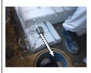
埋設物を避け、斜め に打ち込んでフィル コン R でコーティン グして下さい。
