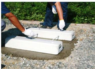
レールに付属の機器足取付け用どぶ付 M12×50mm ボルトを、メンテナンス側ブロックに 1 本、奥側ブロックに 2 本セットします。
