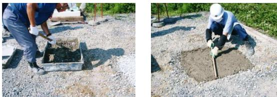
ドライコンクリート 2袋に 15~20 mm程度の砕石を混ぜ、約 4割弱の水で固めに練り混ぜ、捨てコンクリートを作り、砕石の上厚さ約 50 mmに敷き、水平をとります。
