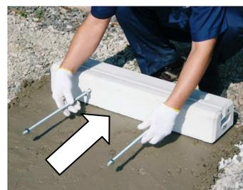
エコベース 1 本目の側面に埋め込まれているインサートに、30 mm の位置にナットをセットした M12 寸切りボルトを、ナット位置までねじ込みます。
