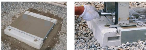
投入したドライコンクリートの表面をコテで仕上げ、養生シートで養生して下さい。
