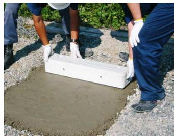
捨てコンクリートが乾かないうちにメンテナンス面、壁からの距離などを確認し、エコベース 1 本目を設置します。
