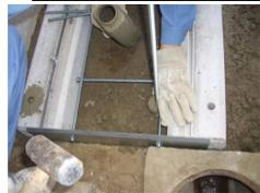
エコベース内のスペースを使い埋設物を避けアンカーを打ち込み、鉄筋と結束して下さい。
