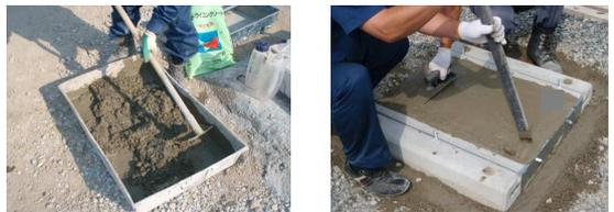
ドライコンクリート1袋につき2.3ℓの水でよく練り混ぜ、エコベース内にブロックの高さまで投入します。ブロック上面まで投入したら凸凹をなくし強度を得るために棒突きをして下さい。
