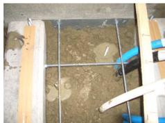
エコベース上面でアンカーをカットし、アンカー上部を逆にして叩き面を下にし、フィルコンRを流し込みながら地中に打ち込んで鉄筋と結束して下さい。
