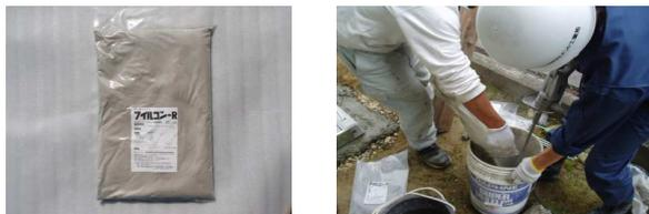
1 袋 5kg につき 0.9ℓの水で高回転ハンドミキサを用いて約 3 分間練り混ぜてください。
