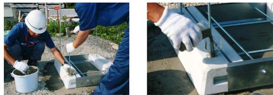
エコベースの貫通穴から地中抵抗アンカーを差し込み、ハンマーで地中に打ち込みながら、練り混ぜたフィルコンRを、打ち込んだアンカーの隙間に注入してください。時々アンカーを動かし、隙間によく入るように注入してください。この作業により地中で鉄筋入りのコンクリートの柱が形成されます。
