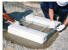
3/8 寸切りボルトに 3/8 ナットを面取りしてある方を内側にしてセットし、3/8 袋ナットでプレートを挟みます。
