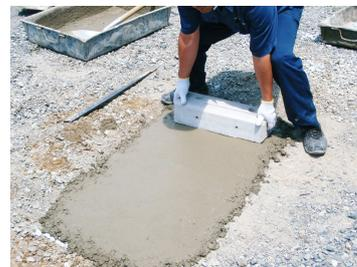
捨てコンクリートが乾かないうちにメンテナンス面、壁からの距離などを確認し、エコベース 1 本目を設置します。
