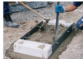
ドライコンクリート1袋につき2.3ℓの水でよく練り混ぜ、エコベース内にブロックの高さまで投入します。ブロック上面まで投入したら凸凹をなくし強度を得るために棒突きをして下さい。
