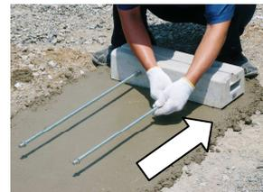
エコベース 1 本目の側面に埋め込まれているインサートに、30 mm の位置にナットをセットした M12 寸切りボルトを、ナット位置までねじ込みます。
