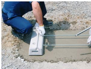
レール間の機器アンカー取付け寸法を測り 2 本目の位置を決め、ボルト端から 15mm の位置にセットしたナット位置まで寸切りボルトをねじ戻し連結します。エコベース 1 本目 2 本目ともナットを 19mm スパナで締めます。
