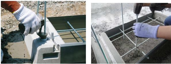
エコベースの貫通穴から地中抵抗アンカーを差し込み、ハンマーで地中に打ち込みながら、練り混ぜたフィルコンRを、打ち込んだアンカーの隙間に注入して下さい。時々アンカーを動かし、隙間によく入るように注入して下さい。この作業により地中で鉄筋入りのコンクリートの柱が形成されます。
