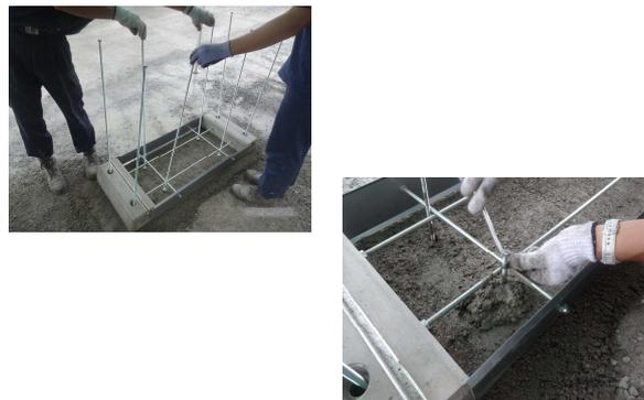
地中抵抗アンカーは8本の打ち込みが必要です。エコベース内も使い地中抵抗アンカーを打ち込み、鉄筋と結束して下さい。
