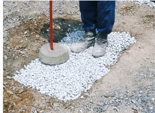
沈み込みを防ぐため砕石を敷き、つき固めます。砕石サイズは 15～20 mm 程度が目安です。
