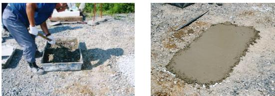
ドライコンクリート 2.5 袋に 15～20 mm 程度の砕石を混ぜ、約 5 割の水で固めに練り混ぜ、捨てコンクリートを作り、砕石の上厚さ約 50 mm に敷き、水平をとります。
