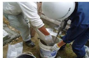
1 袋 5kg につき 0.9ℓの水で高回転ハンドミキサーを用いて約 3 分間練り混ぜて下さい。
