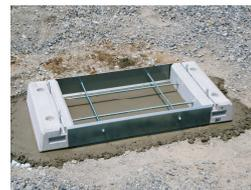
ナット径 (3/8 ナット) に合ったスパナで、通常の人が手で締め付けられる程度の強さで締めます。
